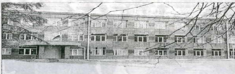
ШКОЛА №1. После проведенной реконструкции школа отличается не только современным обликом и оснащением, но и благоприятными условиями в учебе. В прошлом году она выпустила 14 медалистов и вошла в «золотую пятерку» школ Ленинградской области. ФОТО ТАТЬЯНА МИХАЙЛОВА, «КИРИШСКИЙ ФАКЕЛ».
